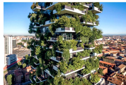
ビルの壁面を緑化
