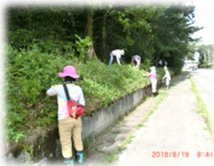
道路法面の雑草刈り
